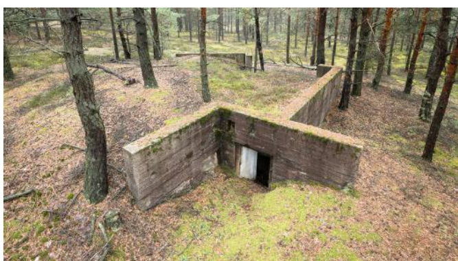
Abb. 81: Blick über den Hof auf das Bauwerk.
