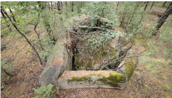
Abb. 63: Der von innen gesprengte Stand 5 mit Blick auf den Bereich vor der frontalen Scharte. Im Unterschied zur gegenüber liegenden Seite ist die Decke hier herabgestürzt.
