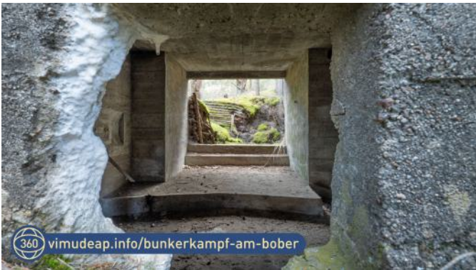
Abb. 118: Blick durch die Scharte für Pak in den Kampfraum und in den Hof.
