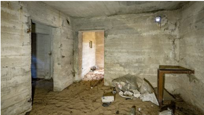
Abb. 90: Bereitschaftsraum mit Blick in Richtung Eingangsverteidigung. Auf dem Sockel rechts war das Gebläse der Lüftungsanlage installiert.
