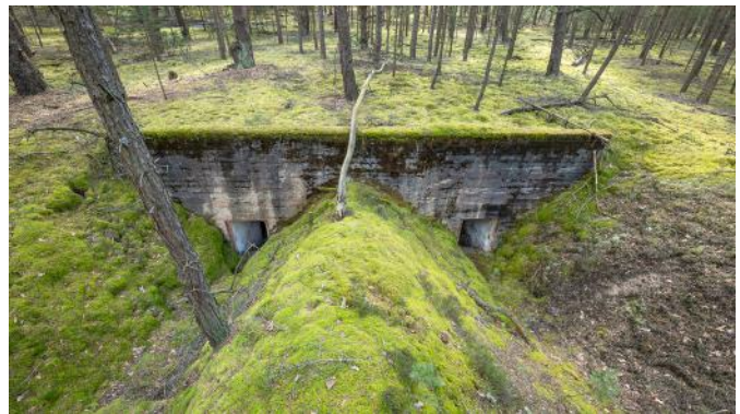
Abb. 132: Blick auf die Hofseite mit den beiden fast verwehten Mannschaftszugängen.
