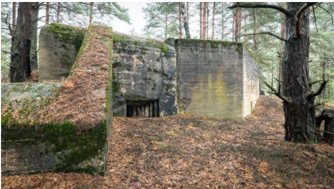
Abb. 74: Ansicht von Süden. Blick über eine Flügelmauer auf die beiden teilweise verschütteten Scharten.
