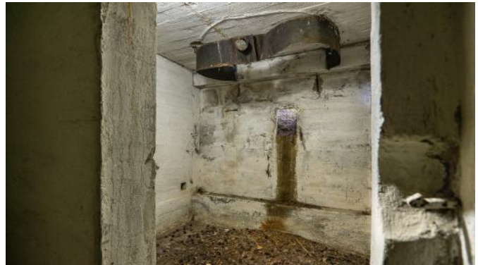
Abb. 91: Kampfraum mit der fast vollständig verschütteten Scharte. Darüber tschechoslowakische Gasleitbleche, vgl. Abb. 111f.
