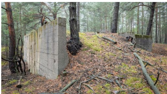
Abb. 95: Blick von der Schartenwand Richtung Hof.
