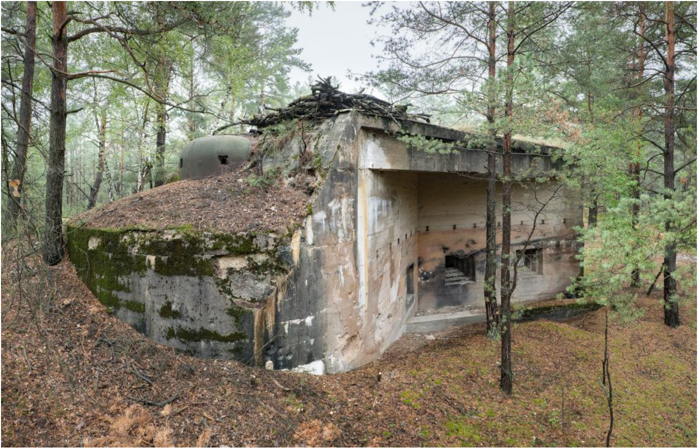
Abb. 29: Dreischartenturm, Mauerscharten und Trennungsgraben am Werk II. Die einstige Position der Verkleidung zur Simulation der überkragenden 3 Meter starken Decke ist an der Kante zum noch vorhandenen Tarnanstrich und an den Resten der Halteträger gut zu erkennen. Spuren vom Einsatz von Flammenwerfern sind nicht zu erkennen.
