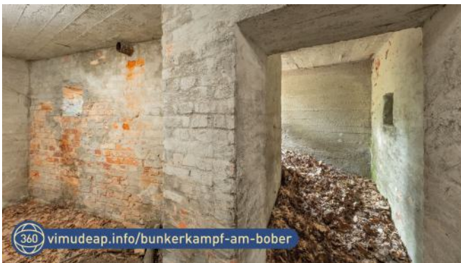
Abb. 109: Blick in die Flankierungsanlage links und in die Gasschleuse mit der Scharte der Eingangsverteidigung.
