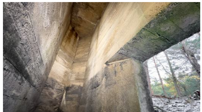
Abb. 53: Blick nach oben in das Innere des rechten Hohlraumes am Schartenstand 1, vgl. Abb. 48. Hohlräume wie dieser dienen der Materialersparnis.
