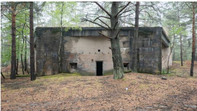
Abb. 30: Hofseite und Scharten zur rückwärtigen Verteidigung des Werkes II. Auch über dem Eingang ist die einstige Position der überkragenden Decke noch gut zu erkennen.
