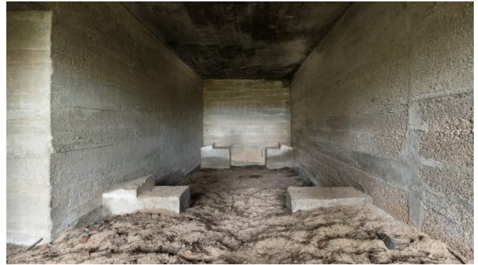
Abb. 124: Blick in den Pak-Unterstellraum in Bauwerk 17. Er ist weniger zugewehrt als der in Bauwerk 16.
