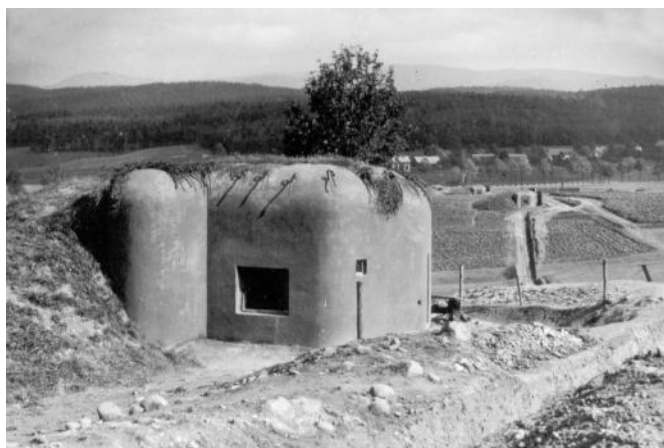
Abb. 44: Befestigungslinie bei Chrastava, unweit von Liberec, im Oktober 1938. Im Vordergrund ein vz. 37 A-160 in verstärkter Ausführung. (Archiv Jan Lakosil)
