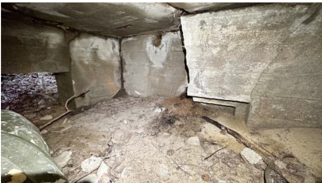
Abb. 104: Verschüttete Eingangsverteidigung und Zugang zum Bereitschaftsraum.
