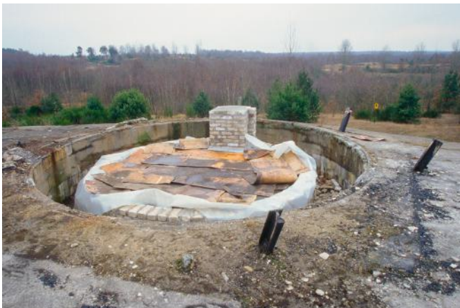
Abb. 4: Die Öffnung für den einstigen Drehturm auf einem Übungs-Infanteriewerk in Döberitz wird verschlossen und ein Einflug für Fledermäuse gemauert. Die schräg eingesetzten Eisenbahnschienen ließen sich auch am zweiten Werk, in Jüterbog, Grafenwöhr 3 und auf historischen Abbildungen 4 nachweisen, 2003.
