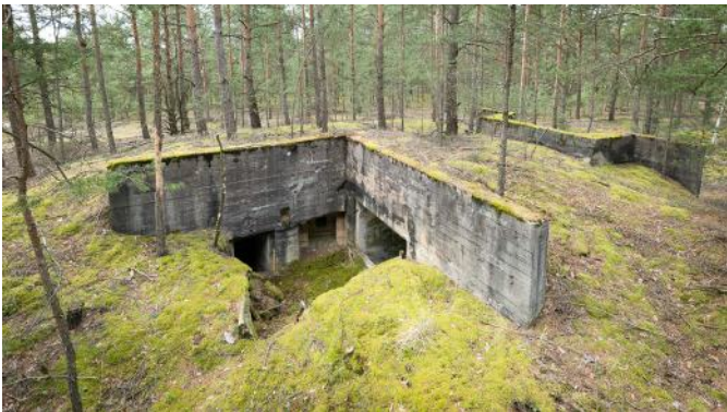
Abb. 116: Übersicht über das Bauwerk. Im Vordergrund Eingang, Flankierungsscharte und Tor zum Kampfraum für Pak.
