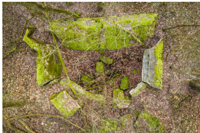
Abb. 5: Die orthogonale Aufnahme lässt den Aufbau eines gesprengten Übungs-Schartenstandes erkennen. Mit einer flankierenden Scharte vor der Flügelmauer links und einer frontalen Scharte rechts oben in der Vorderwand ähnelt er einem tschechischen „Ohrenstand“ (Leichte Befestigung vz. 37, Typ B2-90). Döberitz, 2020.
