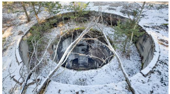
Abb. 41: Position des Drehturmes auf Werk III. In der Tiefe sind links der Zugang zum Munitionsraum und rechts die Türöffnung Richtung Eingang zu erkennen.
