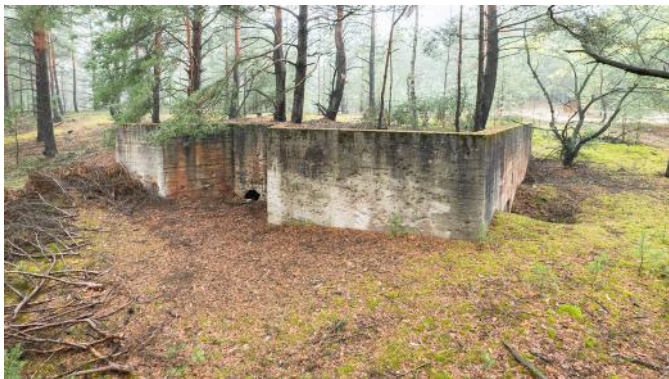
Abb. 129: Blick auf die Schartenfront und die Mannschaftszugänge, die auch hier schon fast verschüttet sind.
