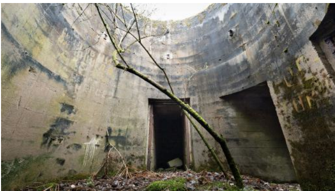
Abb. 40: Raum unter dem entfernten Drehturm in Werk I. Die abgetrennten Stahlträger markieren die Position der Bühne unter dem Turm. Rechts Zugang zum Munitionsraum.
