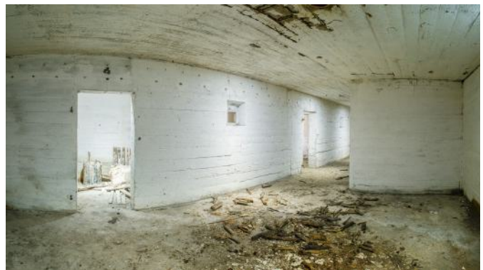
Abb. 133: Panorama im rechten Bereitschaftsraum. Links: Beobachterraum mit Kleinstglocke; Mitte: Scharten der Eingangsverteidigung und Übergang zur Gasschleuse.
