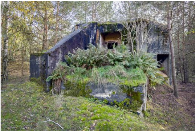
Abb. 6: Übungs-Schartenstand ähnlich einem tschechischen „Ohrenstand“ (Leichte Befestigung vz. 37, Typ A-160). Alle Anschüttungen wurden bis unter das ursprüngliche Niveau entfernt. Dadurch wirkt der farngefüllte Trennungsgraben wie ein eingefasstes Blumenbeet. Königsbrück, 2022.
