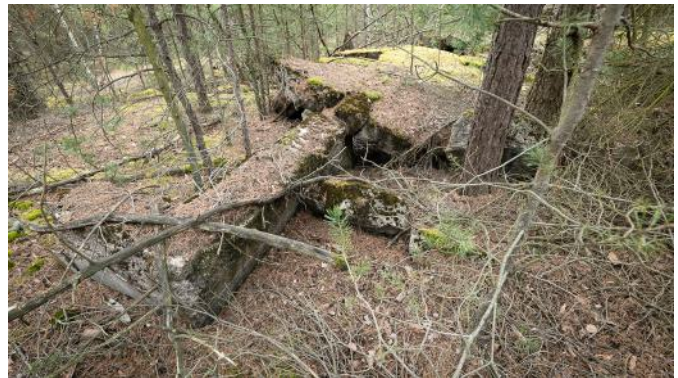
Abb. 103: Reste der linken Scharte. Im Hintergrund die Decke des linken Kampfraumes.
