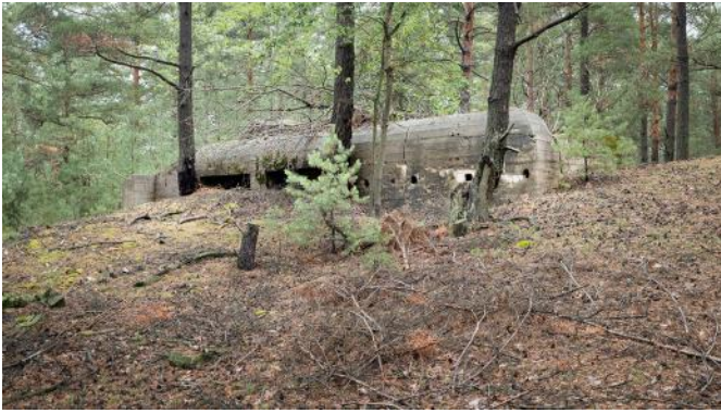
Abb. 59: In dem Maß, wie die Anschüttung erodiert, wird rechts die frontale Scharte von Stand 5 verdeckt. Ähnlichkeiten mit dem Model vz. 37 B1-90.
