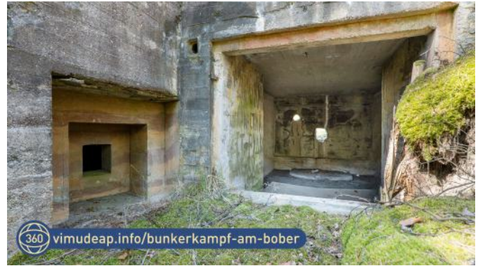
Abb. 117: Die Flankierungsscharte und die Toröffnung vor dem Pak-Kampfraum.
