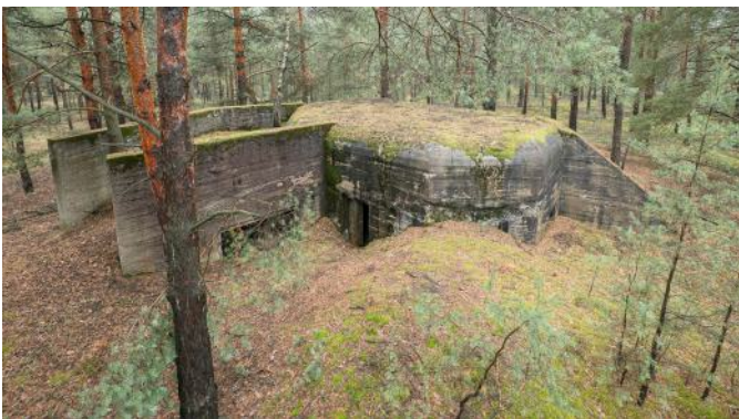
Abb. 78: Die korrespondierende Ansicht zu Abb. 76 von Norden. Rechts die teilverschüttete Scharte mit Flügelmauer.
