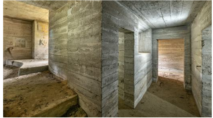
Abb. 119: Blick von der aktiven Gasschleuse in den Pak-Kampfraum links und rechts an der Flankierungsscharte vorbei in Richtung Eingang.
