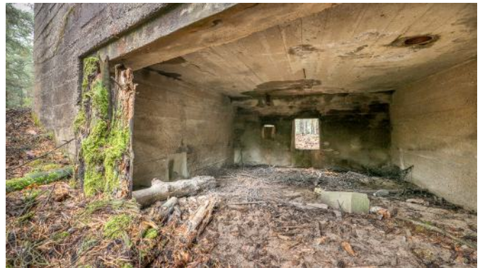
Abb. 77: Blick in den „neuen“ Kampfraum und Reste der Flügeltür.
