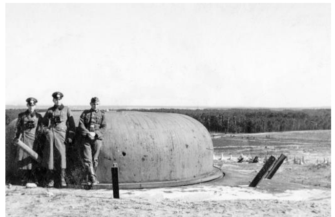
Abb. 28: Geschützdrehturm auf einem Übungswerk, wahrscheinlich Jüterbog. Im Hintergrund tschechoslowakische Betonigel. Auch hier die bereits aus Döberitz bekannten schrägen Eisenbahnschienen, vgl. Abb. 4. (Archiv Jan Lakosil).
