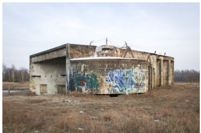
Abb. 3: Ansicht eines Übungs-Infanteriewerkes in Döberitz. Die fehlende Anschüttung rechts lässt die materialsparende Bauweise zur Simulation der Wandstärken erkennen, 2002.
