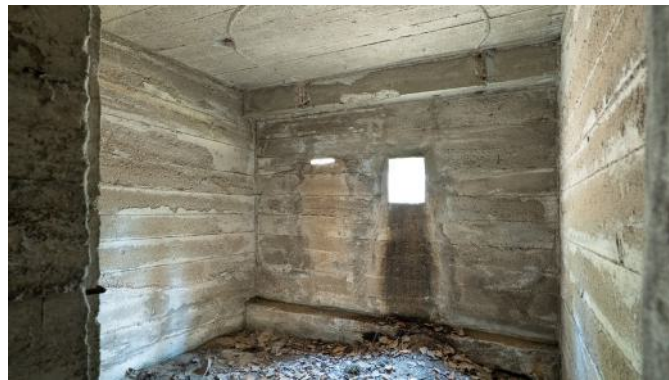
Abb. 84: Der linke Kampfraum. An der Decke Spuren tschechoslowakischer Gasleitbleche, vgl. Abb. 111f.
