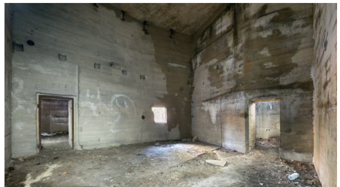
Abb. 39: Kampfräum der linken „Grabenstrieche“ im Werk III. Auch hier sind noch die Positionen der hölzernen Deckenbalken und Leichtbauplatten zu erkennen.
