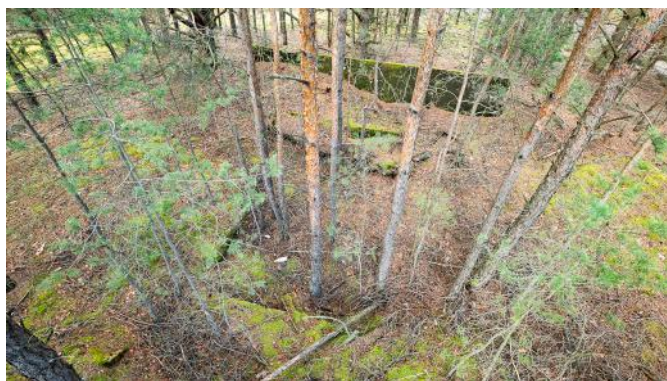
Abb. 141: Die Hochaufnahme des zerstörten Bauwerks 11 lässt dessen Grundriss erkennen.
