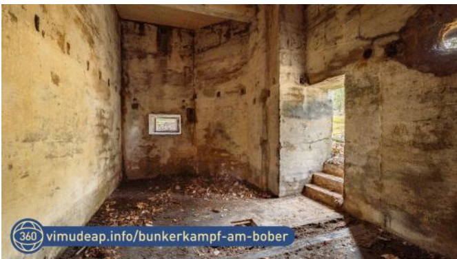
Abb. 50: Innenansicht des Schartenstandes 1 Richtung nördlicher Scharte. Gut zu Erkennen sind die Einlassungen für die Balken zur Simulation der Decke des Kampfraumes.
