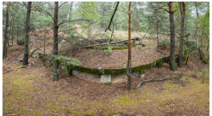
Abb. 31: Die Feindseite des Werkes II mit Dreischartentürmen und Öffnung für den Drehturm. Die erodierte Anschüttung gibt den Blick auf die materialsparende Bauweise frei.
