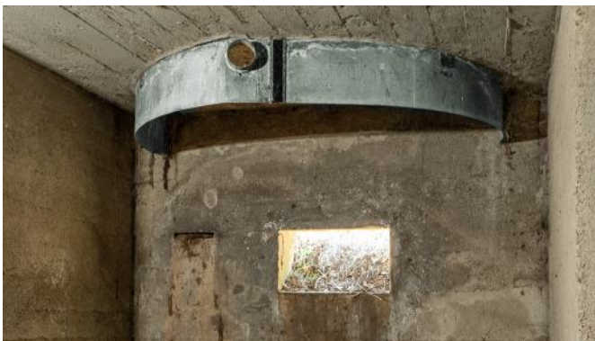
Abb. 111: Scharte mit Beobachtungsschlitz und tschechoslowakischen Pulvergas-Sammlern. (s.a. Abb. 45, 58, 92, 98)
