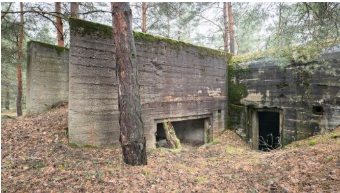
Abb. 76: Der ursprüngliche Eingang in den Schartenstand und der Zugang in den neu hinzugefügten Kampfraum.
