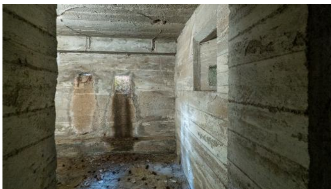
Abb. 83: Rechter Kampfraum. Rechts die Gewehrscharte der Eingangsverteidigung. In der Mitte die Schartenwand.
