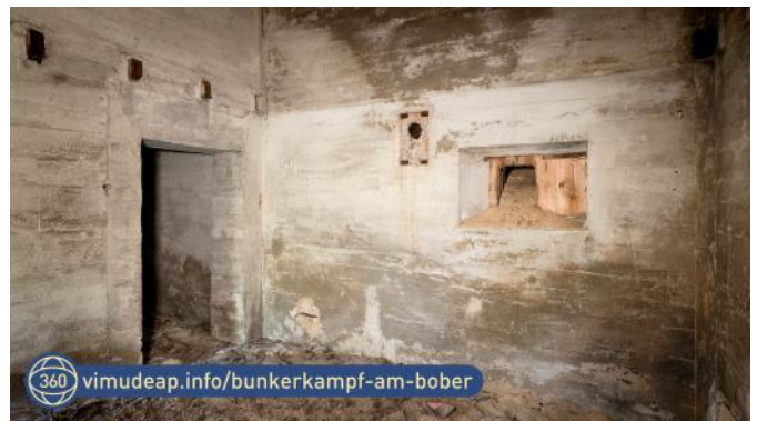
Abb. 66: Hölzerner Schartenverschluss und Handgranatenauswurf hinter der verschütteten frontalen Scharte von Stand 3. Durchgang zum Kampfraum mit flankierender Scharte.
