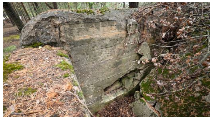
Abb. 64: Im Inneren von Stand 5 ist die frontale Scharte noch gut zu erkennen. Die geringen Mauer- und Deckenstärken und die knappe Bewehrung sind ablesbar.
