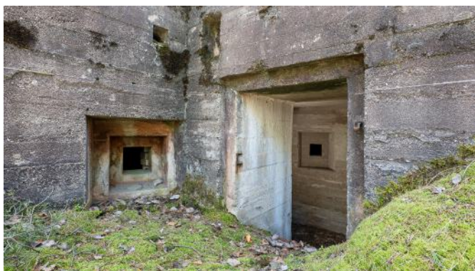
Abb. 85: Eingang mit Flankierungsscharte und Eingangsverteidigung. In der Bildmitte oben eine Nische für den Fernmelde-Außenanschluss.
