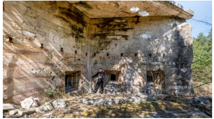
Abb. 35: Florian Steinborn auf dem verschütteten Trennungsgraben am Werk III. Am Boden Reste der Verkleidung zur Simulation der überkragenden 3 Meter starken Decke.
