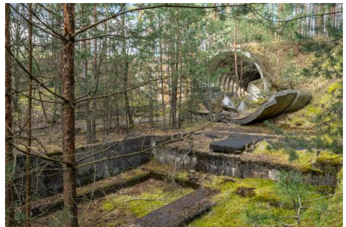
Abb. 16: Sowjetisches Kernwaffenlager. Verladerrampe und Fertigteilbunker vom Typ „Granit“, 2023.
