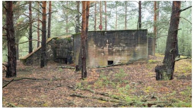
Abb. 73: Links der bereits 1939 verzeichnete MG-Schartenstand mit zwei flankierenden Scharten nach tschechoslowakischem Vorbild. Rechts der später erfolgte Anbau.
