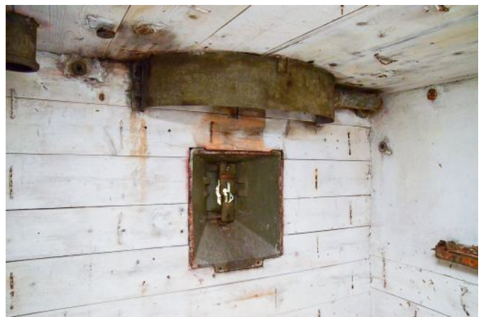
Abb. 58: Frontale Scharte in einem vz. 37 B2-80 bei Chlum im Böhmerwald. An der Decke sind noch die Rollen für die Seilzüge der MG-Lafette vorhanden. (Jan Lakosil)
