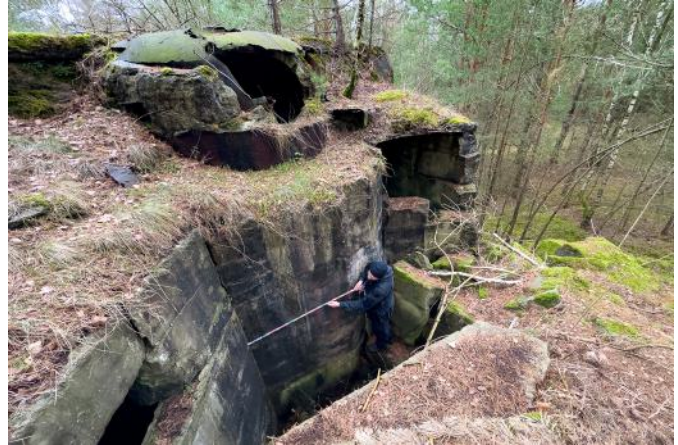
Abb. 7: Die Zerstörungen an diesem Übungs-Infanteriewerk ermöglichen einen Einblick in seine Anatomie. An den Dreischartentürmen erfolgt die Simulation der 3 m Wandstärke der Außenmauer u.a. durch 1,30 m breite Hohlräume. Jüterbog 2020.
