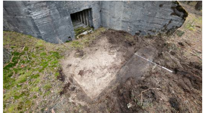
Abb. 49: Teilweise freigelegter Rand des Trennungsgrabens vor der westlichen Scharte an Schartenstand 4. Bei einer Wandstärke von 50 cm hat er ein Innenmaß von 3 x 2 m.
