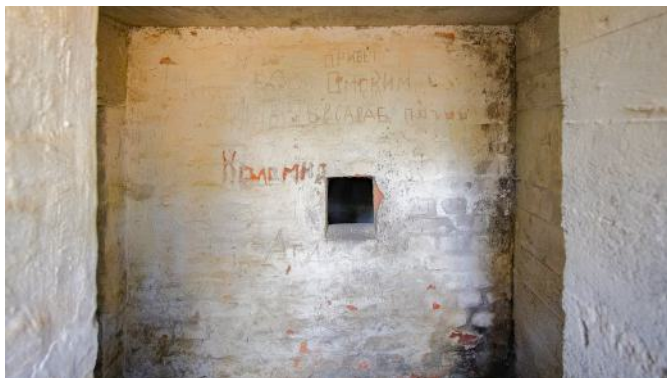
Abb. 97: Blick in die aktive Gasschleuse auf die aus Ziegeln errichtete Eingangsverteidigung.
