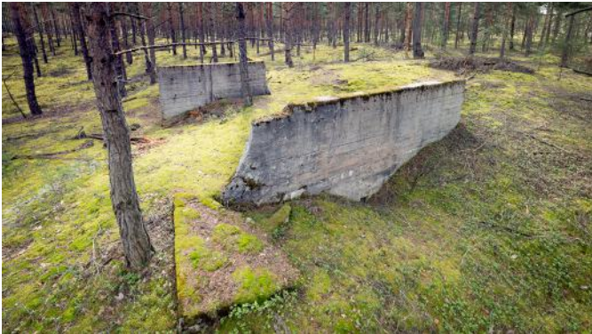
Abb. 88: Blick über die Schartenwand Richtung Hofseite.
