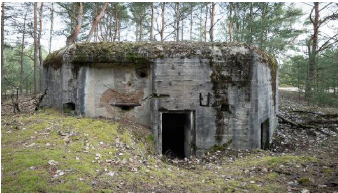
Abb. 48: Rückansicht mit Eingang am Schartenstand 1. Auch hier – links schräg oben neben dem Eingang und rechts unten an der schrägen Mauer – Hohlräume zur Materialersparnis.
