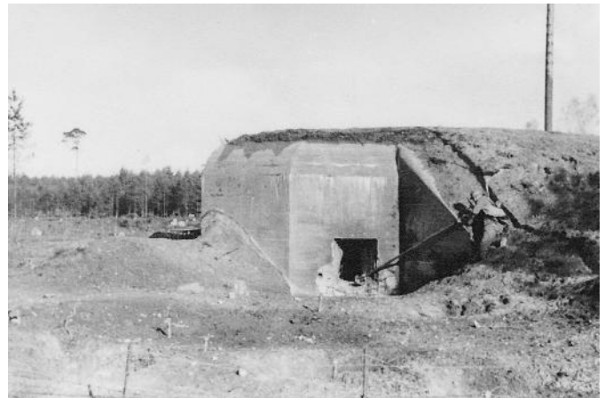
Abb. 151: Die Aufnahme aus einem privaten Album ist beschriftet mit „Bekämpfung eines Ohrenbunkers (franz. Mod.), Roßlau 03.07.1939“. An einem Fragment dieses „Ohrenbunkers“ ließ sich ermitteln, dass er nicht nur größer als die At-truppen auf den Truppenübungsplätzen, sondern auch mit entsprechender Stahlbewehrung ausgeführt worden ist. (Archiv Förderverein für das Militärhistorische Museum Anhalt e.V., Detlef Güth)
