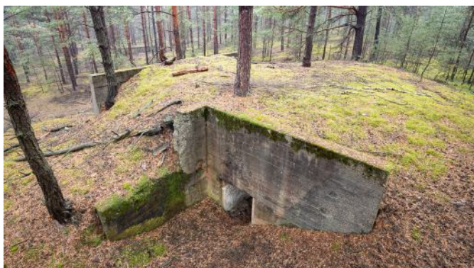
Abb. 99: Blick über das Bauwerk. Im Hintergrund Bauwerk 16 (Pak-Unterstellraum m. Gruppe, S. 31)
