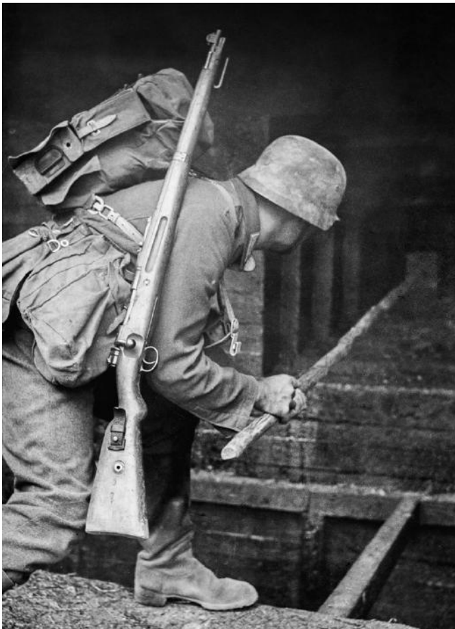
Abb. 150: Im Pressebild vom 15.08.1940 bringt ein Sturmponier eine 3 kg Sprengladung mit einer Stange (Stangenladung) an einer Scharte eines Übungswerkes in Position. Im speziellen Pionier-Tornister ist eine weitere 3 kg Ladung zu erkennen. (INTERFOTO/Marz)
