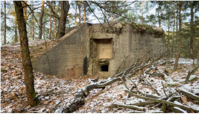
Abb. 46: Südliche Scharte mit Flügelmauer des Schartenstandes 1. Über der Scharte ist ein Hohlraum zur Materialersparnis zu erkennen, der einst maskiert war.
