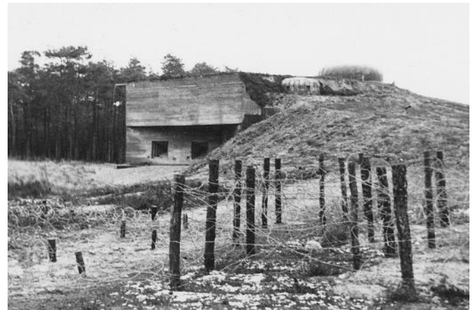
Abb. 27: Übungswerk, wahrscheinlich auf dem Truppenübungsplatz Grafenwöhr. Erkennbar die Auswürfe für Handgranaten an den Mauerscharten und die Kante des Trennungsgrabens. (Archiv Jan Lakosil)
