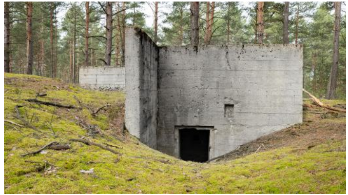
Abb. 87: Eingang, Nische für den Fernmelde-Außenanschluss und im Hintergrund die Rückseite der Schartenwand.
