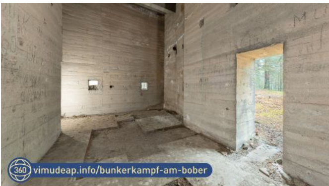
Abb. 38: Im Werk II sind die früheren Positionen der Deckenbalken und Leichtbauplatten (Heraklit) zu erkennen. Letztere markieren am Boden die ursprüngliche Raumaufteilung.
