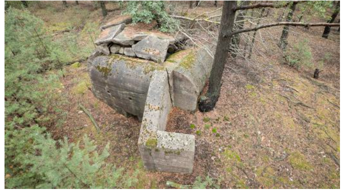
Abb. 62: Blick auf die teilverschüttete Scharte und Flügelmauer von Stand 5. Die Sprengung von innen hat die Decke in diesem Bereich angehoben und zerbrochen.
