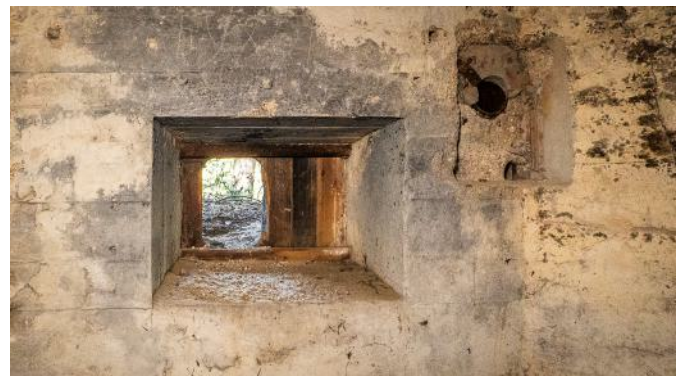
Abb. 51: Ansicht der nordwestlichen Scharte von innen im Schartenstand 2. Der Schieber zum Verschluss der hölzernen Scharte fehlt. Rechts Handgranatenauswurf ohne Metallteile.
