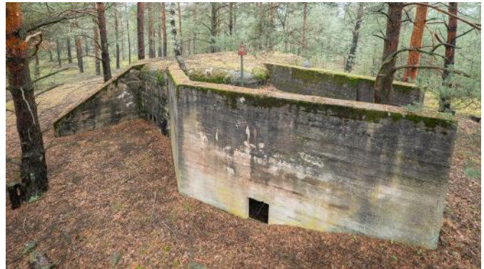
Abb. 75: Blick auf das Bauwerk von Westen. Beide Scharten und die Position und Ausdehnung des neu hinzugefügten Kampfraumes sind gut zu erkennen.
