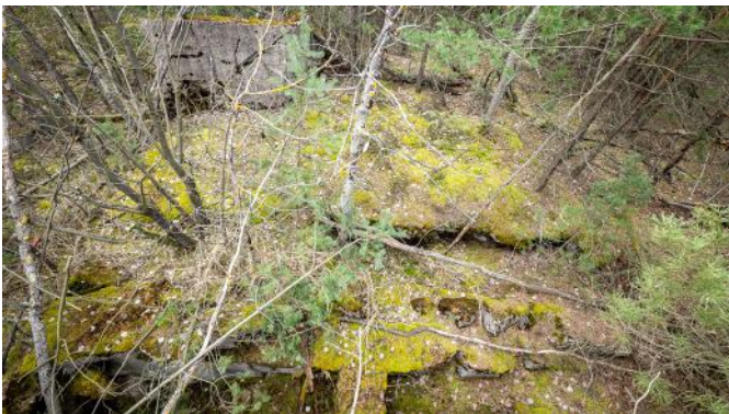
Abb. 106: Blick über das Bauwerk Richtung Hof. Unten am Rand in der Bildmitte ist ein Stück der Trennwand zwischen den beiden Kampfräumen zu erkennen.
