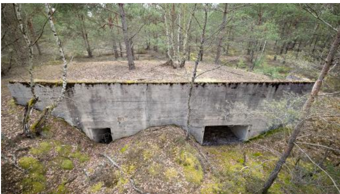
Abb. 127: Die Hofseite von Bauwerk 17. Das Tor zum Pak-Unterstellraum ist weniger verschüttet als in Bauwerk 16.
