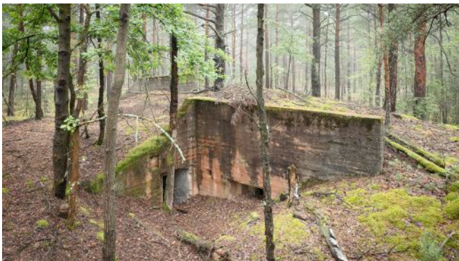
Abb. 113: Blick über das Bauwerk von der Hofseite Richtung MG-Scharte.
