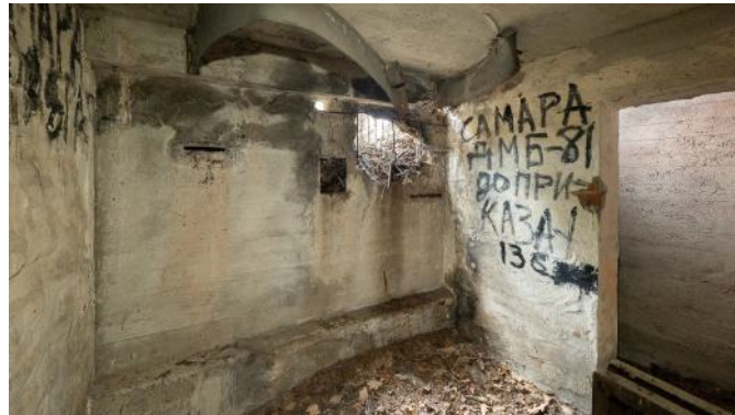
Abb. 98: Ein Durchschuss neben der Scharte im Kampfraum. Zerstörte tschechoslowakische Gasleitbleche, vgl. Abb. 111f.
