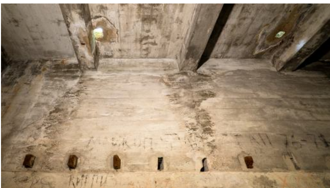
Abb. 52: Öffnungen für Periskope an der Decke des Schartenstandes 4. Abgetrennte Holzbalken der Decke des Kampfraumes. Kyrillische Inschriften.
