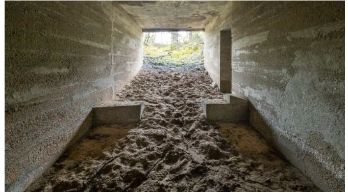
Abb. 126: Der „Gegenschuss“ zur Aufnahme in Abb. 124, ebenfalls in Bauwerk 17.
