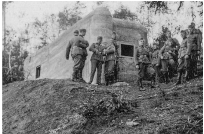
Abb. 57: Diese Aufnahmen eines vz. 37 B2-80 bei Strýbro zeigt ihn ohne Zerschellerschicht und Erdanschüttung. Dadurch ist der seltene gleichzeitige Blick auf beide Scharten möglich, ca. Oktober 1938. (Archiv Jan Lakosil)
