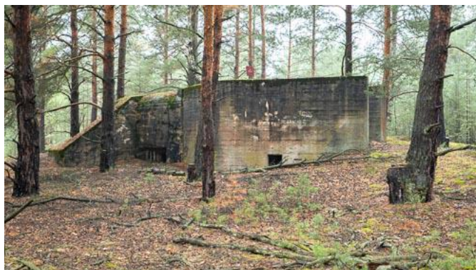
Rys. 73: Po lewej, schron dla karabinu maszynowego z dwiema strzelnicami flankującymi, wzorowane na modelu czechosłowackim, zarejestrowanym już w 1939 roku. Po prawej, późniejsza rozbudowa.
