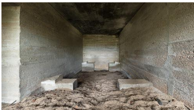
Rys. 124: Widok na garaż, izbę pak w Schronie nr 17, który jest mniej zaśmiecony niż ten w Schronie nr 16.
