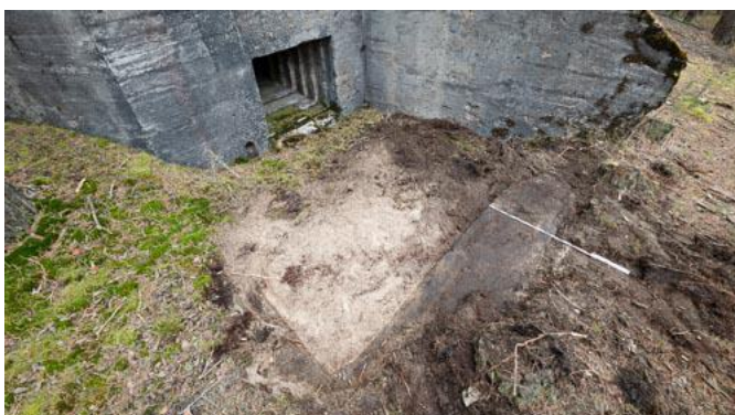
Rys. 49: Częściowo odsłonięta krawędź rowu diamentowego przed zachodnią strzelnicą w Schronie nr 4. Przy grubości ściany 50 cm ma on wewnętrzny wymiar 3 x 2 m.
