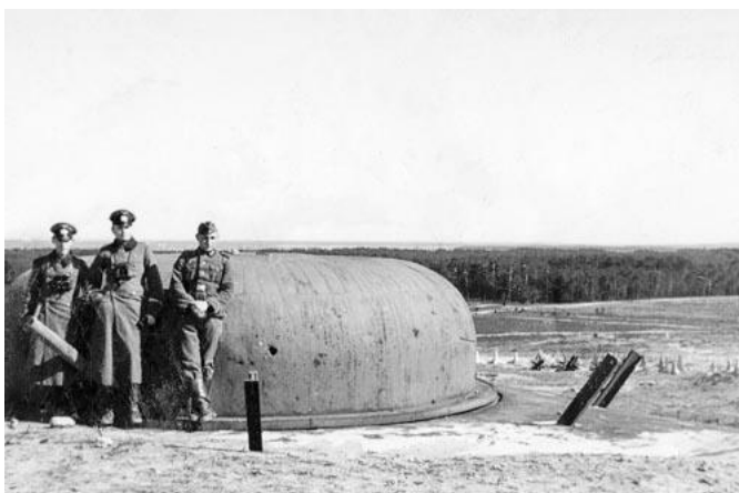
Rys. 28: Obrotowa wieża artyleryjska na poligonie, prawdopodobnie Jüterbog. W tle czeskosłowackie betonowe jeże. Widać również pochylone tory kolejowe znane już z Döberitz, por. rys. 4 (Archiwum Jana Lakosila).
