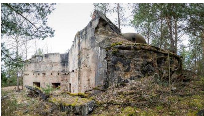
Rys. 34: Trójstrzelnicowa kopuła i strzelnice w ścianach w obiekcie Werk I. Części zawalonego stropu przykrywają rów diamentowy.
