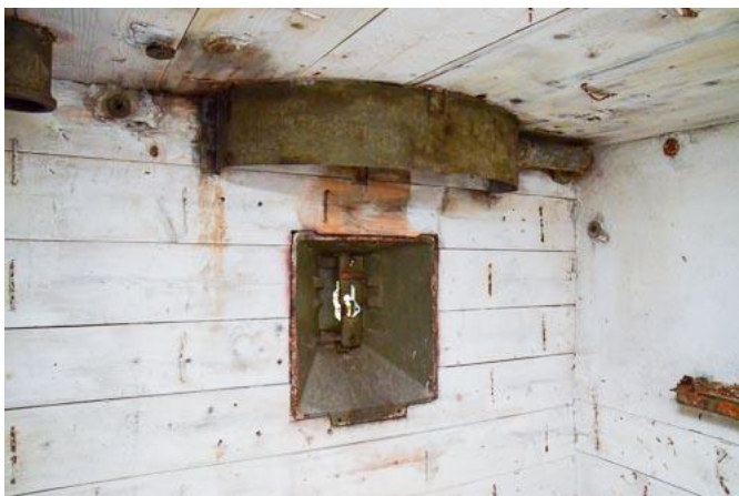
Rys. 58: Przedni otwór strzelniczy schronu wz. 37 podtypu B2-80 w pobliżu Chlum w Lesie Czeskim. Na suficie zachowały się krążki do naciągania lin podstawy karabinu maszynowego. (Jan Lakosil)
