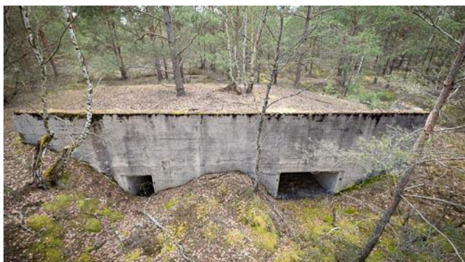
Ryc. 127: Zewnątrz Schronu nr 17. Brama do garażu-izby dla armaty pak jest mniej zasypana niż w Schronie nr 16.
