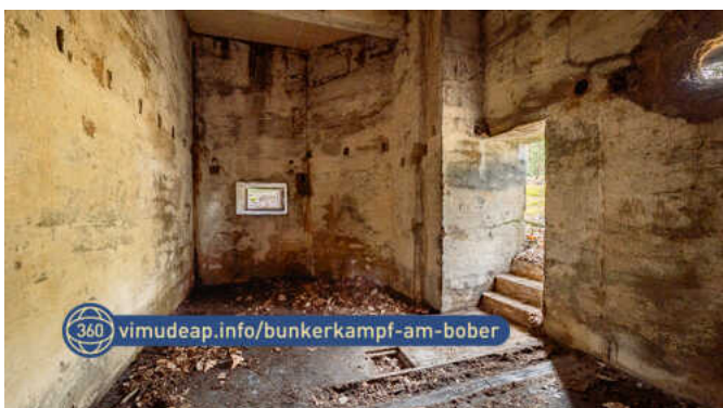
Rys. 50: Widok wnętrza Schronu nr 1 w kierunku strzelnicy północnej. Wgłębienia na belki symulujące sufit przedziału bojowego są wyraźnie widoczne.
