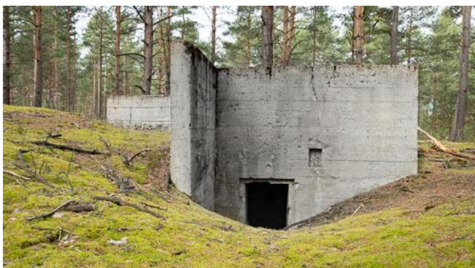
Rys. 87: Wejście, wnęka na zewnętrzne przyłącze telekomunikacyjne i w tle tylna strona ściany wnęki.
