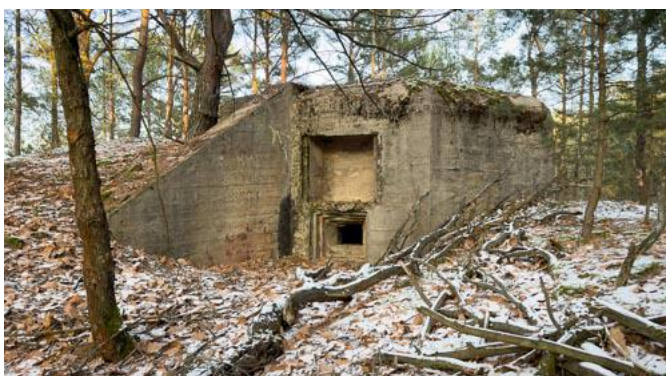
Fig. 46: Południowy otwór strzelniczy ze ścianą skrzydłową Schronu nr 1. Nad strzelnicą widoczna jest wnęka oszczędzająca materiał, która niegdyś była zamaskowana.
