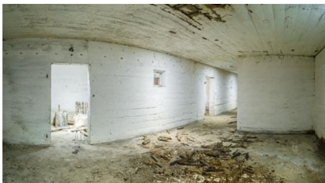
Rys. 133: Panorama w prawym pomieszczeniu pogotowia. Po lewej: pomieszczenie obserwatora z małym dzwonem obserwacyjnym, środek: strzelnice obrony wejścia i przejście do służby gazowej.
