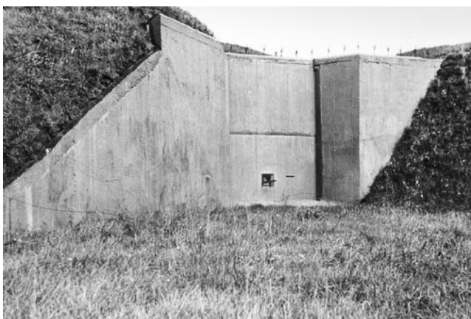
Rys. 69: Zdjęcie współczesne schronu na Westwall w 1939 r.: Schron bojowy dla CKM nr 635 (Regelbau 105) w pobliżu Bous/Saar. (BArch, Bild 146-1985-073-20 / b.d.)
