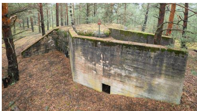
Rys. 75: Widok schronu od strony zachodniej. Oba otwory strzelnicze oraz położenie i zasięg nowo dodanego przedziału bojowego są wyraźnie rozpoznawalne.
