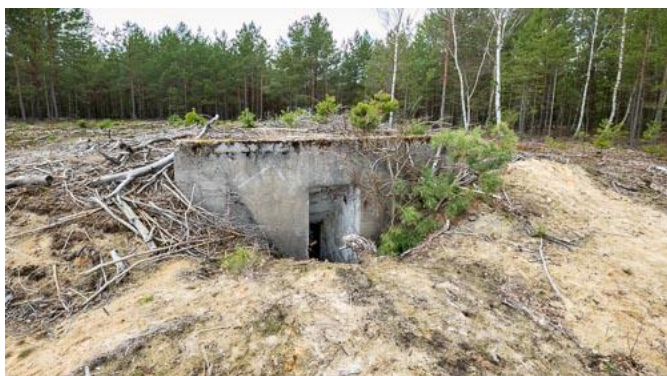
Rys. 126: "Przeciwnie ujęcie" do zdjęcia na Rys. 124, również w Schronie nr 17.
