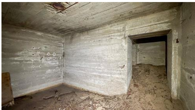
Rys. 140: Podobnie jak w konstrukcji standardowej, w Schronie nr 15 nie ma obrony wejścia.
