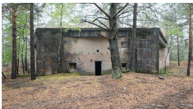
Rys. 29: Kopuła trójstrzelnicowa, otwory strzelnicze w ścianach i rów diamentowy w Werku II. Dawne położenie obudowy symulującej zwisający strop o grubości 3 metrów można wyraźnie zobaczyć na krawędzi wciąż istniejącej farby maskującej i na pozostałościach belek oporowych. Nie można rozpoznać żadnych śladów użycia miotaczy ognia.
