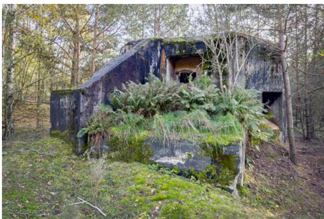
Rys. 6: Schron ćwiczebny podobny do czeskiego "schronu uszatego" (obiekt lekkiej fortyfikacji wz. 37, podtyp A-160). Wszystkie nasypy zostały usunięte poniżej pierwotnego poziomu. Dzięki temu wypełniony paprociami rów diamentowy wygląda jak obramowany kwietnik. Königsbrück, 2022 r.
