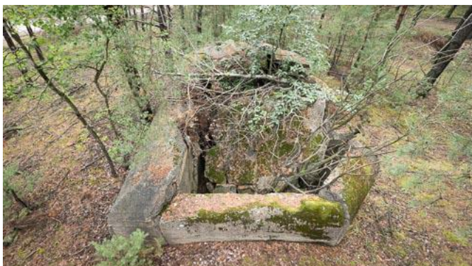
Rys. 63: Schron nr 5, wysadzony od wewnątrz, z widokiem na obszar przed strzelnicą czołową. W przeciwieństwie do przeciwległej strony, tutaj strop się zawalił.
