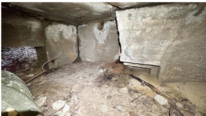
Rys. 104: Zasypana obrona wejścia i dostęp do izby gotowości.
