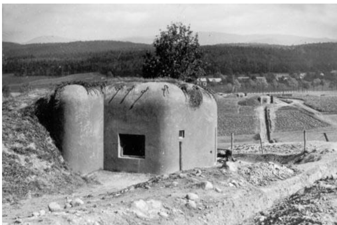
Rys. 44: Linia umocnień w pobliżu Chrastavy, niedaleko Liberca, w październiku 1938 r. Na pierwszym planie schron wz. 37 podtyp A-160 w wersji wzmocnionej. (Archiwum Jana Lakosila)
