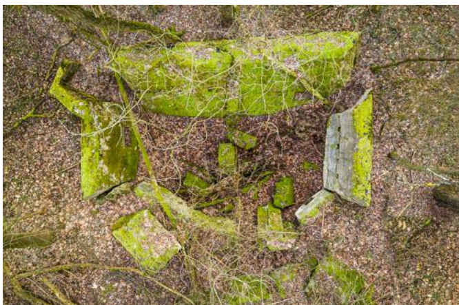
Rys.5: Zdjęcie ortogonalne przedstawia konstrukcję wysadzonego schronu ćwiczebnego. Z „uchem” flankującym przed strzelnicą boczną po lewej stronie i strzelnicą czołową w prawym górnym rogu, przypomina on czeski schron typu „Řopik” (obiekt lekkiej fortyfikacji wz. 37, podtyp B2-90). Döberitz, 2020.
