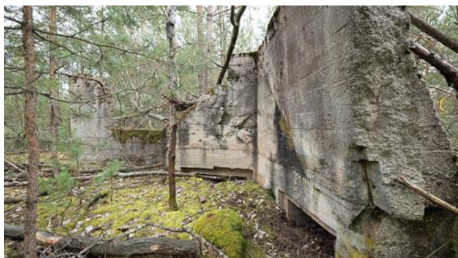
Rys. 102: Wnętrze z zasypaną strzelnicą flankującą i zasypanym wejściem po prawej stronie na pierwszym planie.
