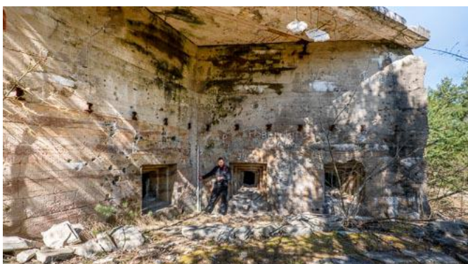
Rys. 35: Florian Steinborn nad zasypanym rowem diamentowym w Werku III. Pozostałości obudowy na ziemi symulujące zwisający strop o grubości 3 metrów.
