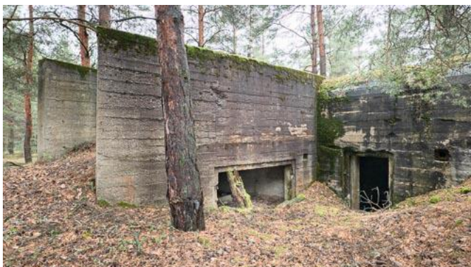
Rys. 76: Pierwotne wejście do schronu i wejście do nowo dobudowanego przedziału bojowego.
