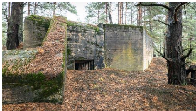
Rys. 74: Widok od strony południowej. Widok przez ścianę skrzydlową na dwa częściowo zasypane otwory strzelnicze.
