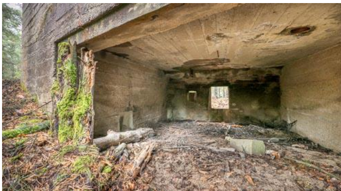
Rys. 77: Widok do "nowego" przedziału bojowego i pozostałości podwójnych drzwi.
