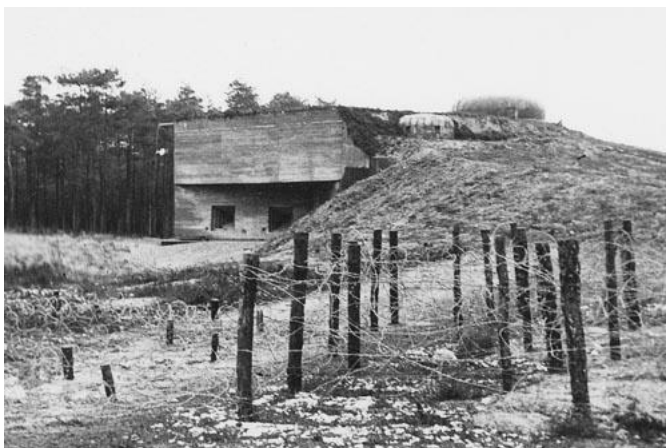
Rys. 27: Schron szkoleniowy, prawdopodobnie na poligonie wojskowym Grafenwoehr. Zrzutnie granatów ręcznych przy otworach strzelniczych i na krawędzi rowu diamentowego są rozpoznawalne. (Archiwum Jana Lakosila)
