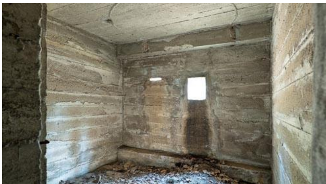
Rys. 84: Lewa izba bojowa. Ślady czechosłowackich czerpni gazów prochowych na suficie, por. rys. 111f.
