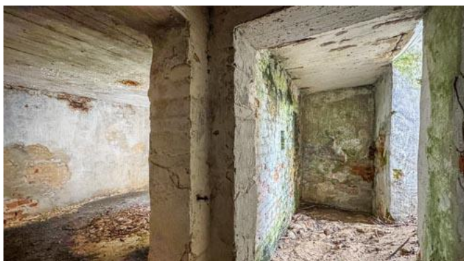
Rys. 137: Widok wnętrza z rurą wentylacyjną i obroną wejścia w Schronie nr 25.
