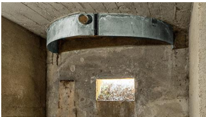
Rys. 111: Strzelnica ckm ze szczeliną obserwacyjną i czechosłowacką czerpnią gazu. (patrz także Rys. 45, 58, 92, 98)
