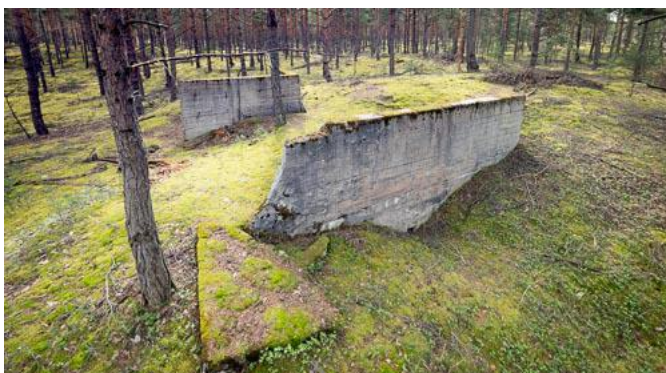
Rys. 88: Widok na ścianę w kierunku wnętrza.
