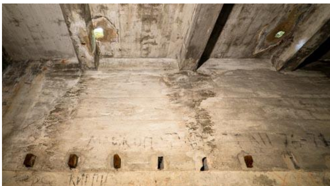
Rys. 52: Otwory na peryskopy na stropie Schronu nr 4. Oddzielone drewniane belki w suficie przedziału bojowego. Napisy cyrylicą.
