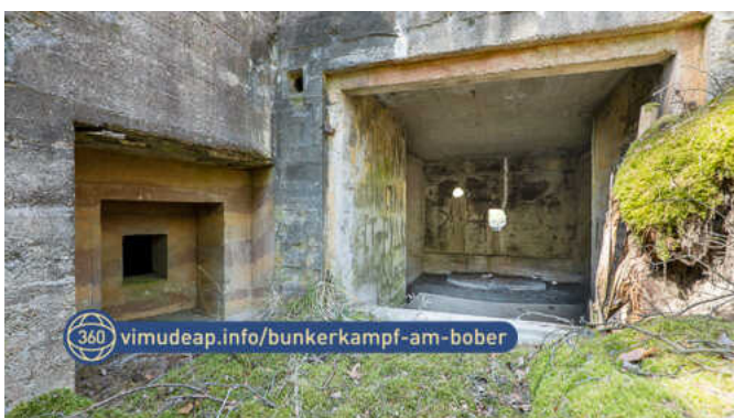
Rys. 117: Strzelnica flankująca i otwór bramy przed przedziałem bojowym armaty ppanc.
