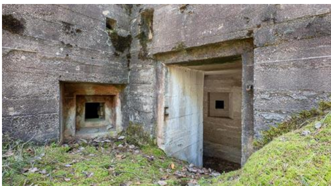
Rys. 85: Wejście ze strzelnicą flankującą obronę wejścia. W górnej środkowej części zdjęcia znajduje się wnęka na zewnętrzne przyłącze telekomunikacyjne.
