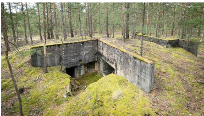
Rys. 116: Przegląd konstrukcji. Na pierwszym planie wejście, strzelnica flankująca i drzwi do przedziału bojowego dla armaty ppanc.
