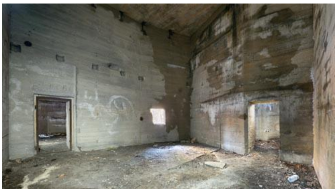
Rys. 39: Izba bojowa z lewej strony w Werku III, gdzie nadal można rozpoznać mocowanie drewnianych belek stropowych i lekkich paneli.
