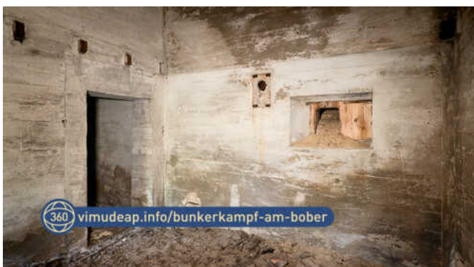
Rys. 66: Drewniane zamknięcie strzelnicy i zrzutnia granatów ręcznych za zasypką strzelnicą czołową Schronu nr 3. Przejście do izby bojowej z bocznej strzelnicą.
