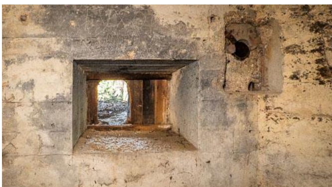
Rys. 51: Widok północno-zachodniego otworu strzelniczego od wewnątrz w Schronie nr 2. Brak zasuwki zamykającej drewniany otwór strzelniczy. Po prawej zrzutnia granatów bez metalowych części.
