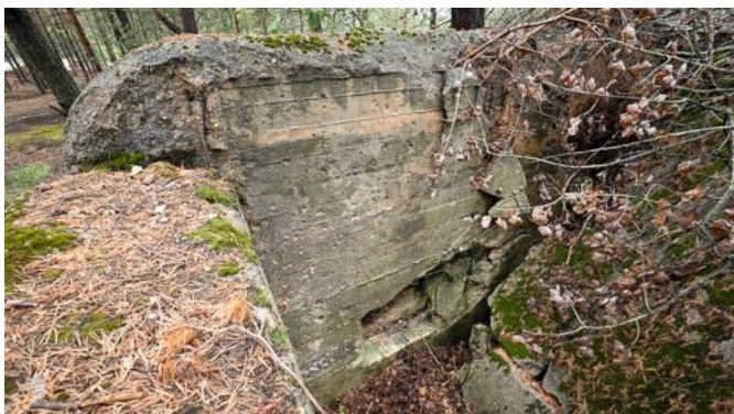
Rys. 64: Wewnątrz Schronu nr 5, strzelnica czołowa jest nadal wyraźnie rozpoznawalna. Widać niewielką grubość ścian i stropu oraz skąpe zbrojenie.
