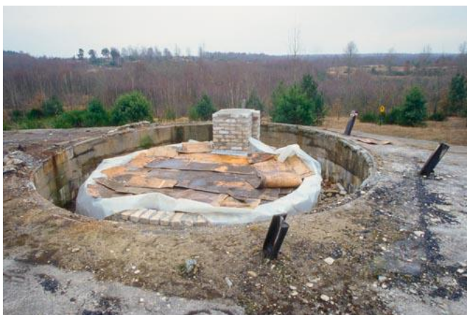
Rys. 4: Otwór dla wieży obrotowej na stropie schronu ćwiczebnego w Döberitz jest zamknięty, a wejście dla nietoperzy zamurowane. Ukośnie wstawione odcinki szyn kolejowych można było również znaleźć na drugim takim schronie, w Jüterbog, na poligonie Grafenwoehr [3] i na historycznych ilustracjach [4] , 2003.
