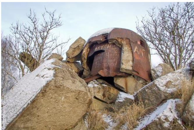
Rys. 2: Pozostałości makiety kopuły trójstrzelnicowej na wysadzonym schronie ćwiczebnym dla piechoty. Otaczający beton nie wykazuje "poważnego" stalowego zbrojenia. Döberitz, 2002.
