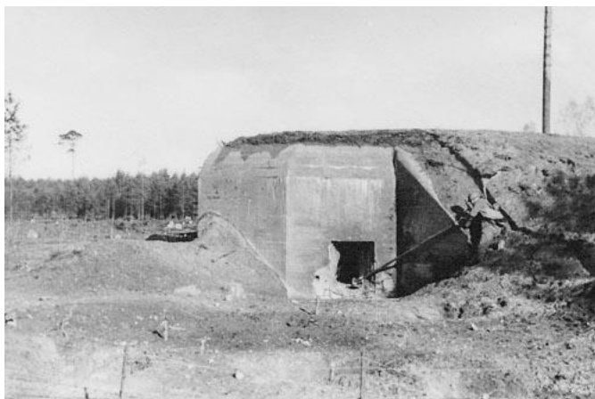
Rys. 151: Zdjęcie z prywatnego albumu oznaczone jako "Walka z schronem „uszatym“ (mod. francuska), Roßlau 03.07.1939". Fragment tego "Ohrenbunker" pokazał, że był on nie tylko większy niż makiety na poligonach, ale także został zbudowany z odpowiednim wzmocnieniem stalowym. (Archiv Förderverein für das Militärhistorische Museum Anhalt e.V., Detlef Güth).
