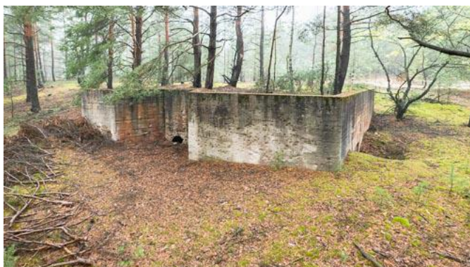
Rys. 129: Widok na ścianę ze strzelnicą i wejścia dla załogi, które również są tu prawie zasypane.
