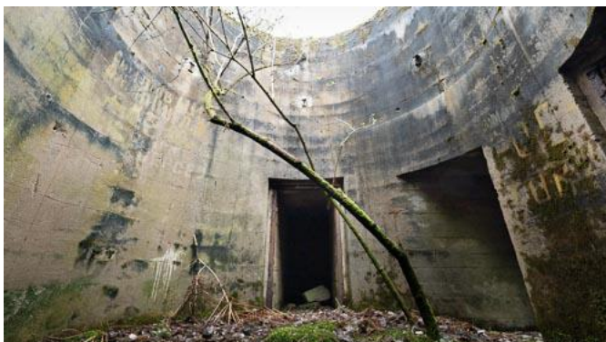
Rys. 40: Pomieszczenie pod usuniętą wieżą obrotową w Werku I. Odcięte stalowe dźwigary wyznaczają położenie platformy pod wieżą. Wejście do pomieszczenia amunicyjnego po prawej stronie.
