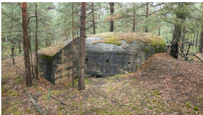
Rys. 61: Strzelnica boczny Schronu nr 3 jest prawie zasypana. Ściana skrzydła jest znacznie krótsza w tych modelach niż w modelach z dwoma bocznymi otworami strzelniczymi.
