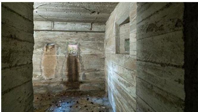
Rys. 83: Prawa izba bojowa. Po prawej stronie strzelnica obrony wejścia. Pośrodku ściana ze strzelnicą ckm.
