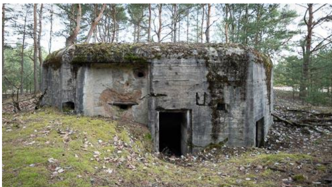
Rys. 48: Widok z tyłu z wejściem przy Schronie nr 1. Tutaj również - po przekątnej u góry po lewej stronie obok wejścia i u dołu po prawej stronie na pochylej ścianie - wgłębienia w celu zaoszczędzenia materiału.
