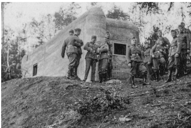
Rys. 57: Zdjęcie schronu wz. 37 podtypu B2-80 w pobliżu Stříbro pokazuje go bez warstwy płaszcza kamiennego i ziemi. Pozwala to na rzadki jednoczesny widok obu strzelnic, ok. października 1938 r. (Archiwum Jana Lakosila).
