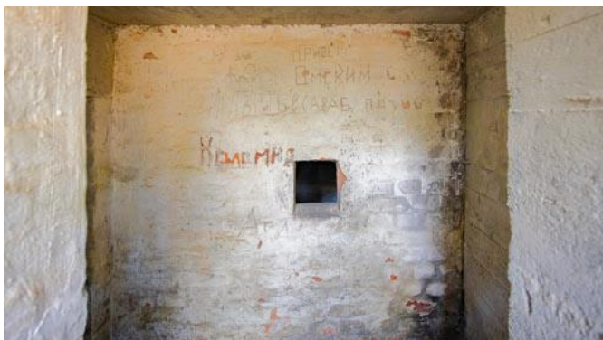
Rys. 97: Widok murowanej obrony wejścia w czynnej służbie gazowej.
