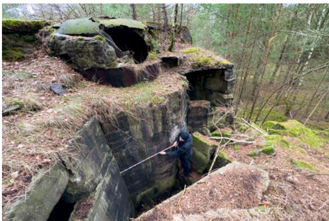
Rys. 7: Uszkodzenie tego schronu ćwiczebnego dla piechoty zapewnia wgląd w jego budowę. Zewnętrzna ściana o grubości 3 m jest symulowana między innymi przez wnęki o szerokości 1,30 m. Jüterbog 2020.
