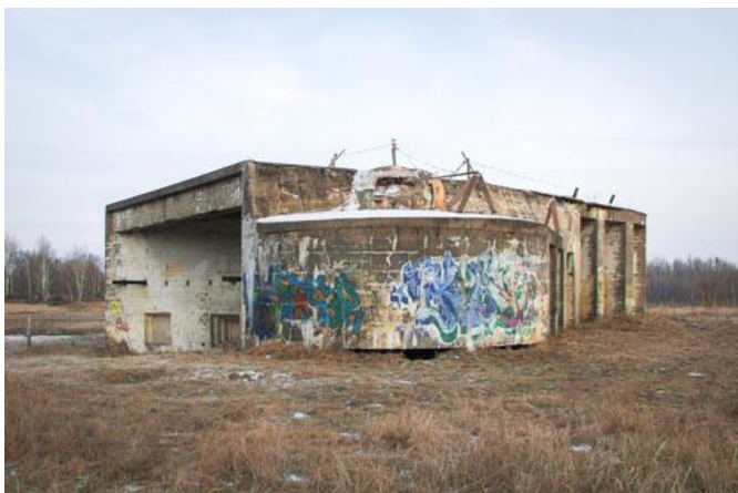
Rys. 3: Widok schronu ćwiczebnego dla piechoty w Döberitz. Brak nasypu po prawej stronie wskazuje na materiałoooszczędną metodę budowy zastosowaną do symulacji grubości ścian, 2002.
