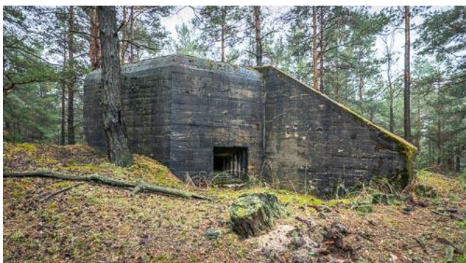
Rys. 47: Strzelnica zachodnia ze ścianą skrzydłową Schronu nr 4. Znajdujący się przed nią rów diamentowy jest zasypany. Większość nasypu czołowego uległa erozji.
