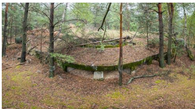
Rys. 31: Widok od czola Werku II z kopułami trójstrzelnicowymi i otworem na wieżę obrotową. Erozja nasypu ujawnia metodę budowy oszczędzającą materiał.
