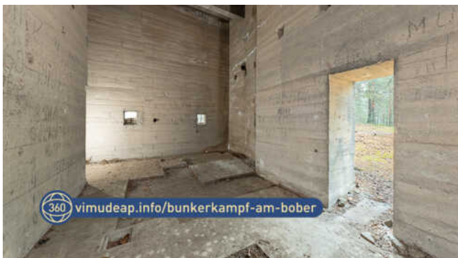
Rys. 38: W Werku II można rozpoznać dawne położenie belek stropowych i lekkich paneli (Heraklit). Te ostatnie oznaczają oryginalny układ pomieszczeń na podłodze.
