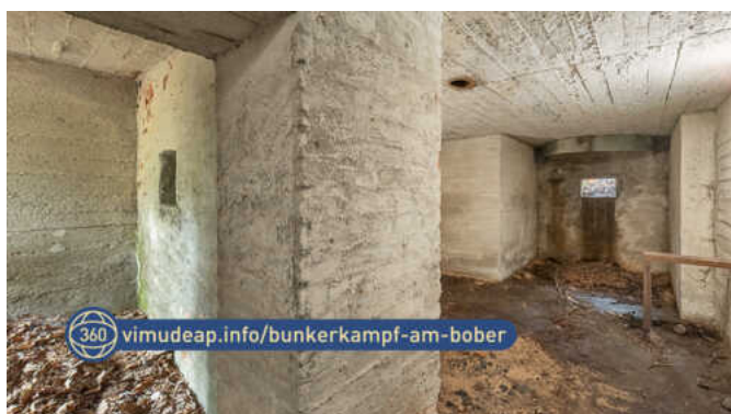
Rys. 110: Po lewej śluzę gazowa z obroną wejścia, a po prawej dyżurka i pomieszczenie bojowe.
