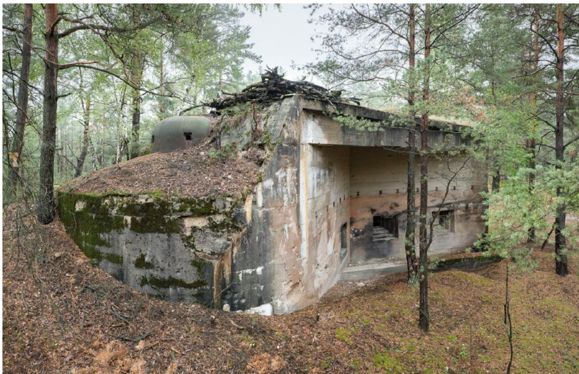
Rys. 29: Kopuła trójstrzelnicowa, otwory strzelnicze w ścianach i rów diamentowy w Werku II. Dawne położenie obudowy symulującej zwisający strop o grubości 3 metrów można wyraźnie zobaczyć na krawędzi wciąż istniejącej farby maskującej i na pozostałościach belek oporowych. Nie można rozpoznać żadnych śladów użycia miotaczy ognia.
