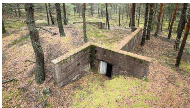
Rys. 81: Widok od tyłu na schron.
