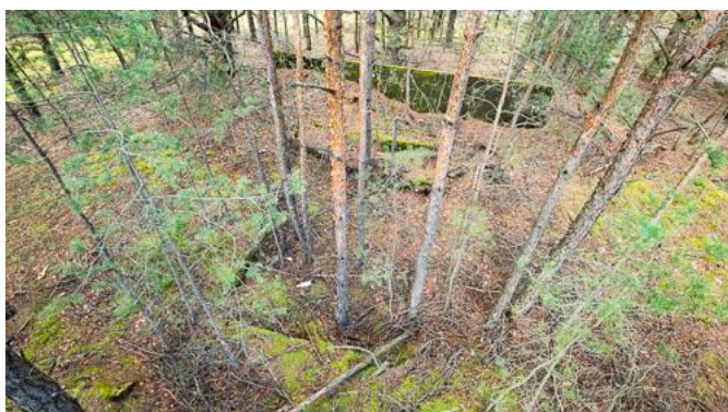
Rys. 141: Zbliżenie w widoku z góry zniszczonego Schronu nr 11 pokazuje jego plan.
