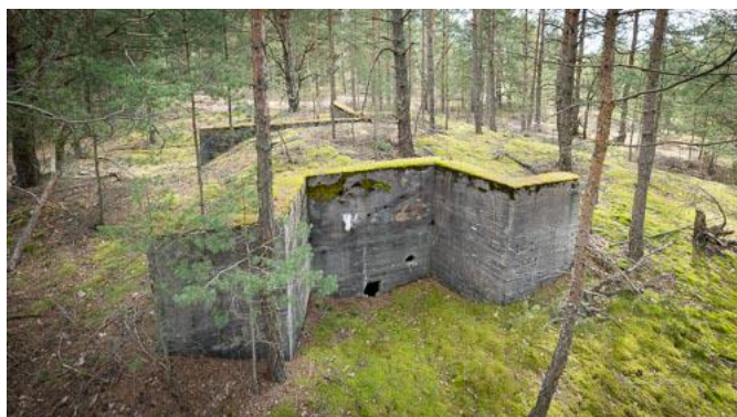
Rys. 120: Widok ogólny w kierunku wnętrza. Na pierwszym planie strzelnica armaty ppanc.
