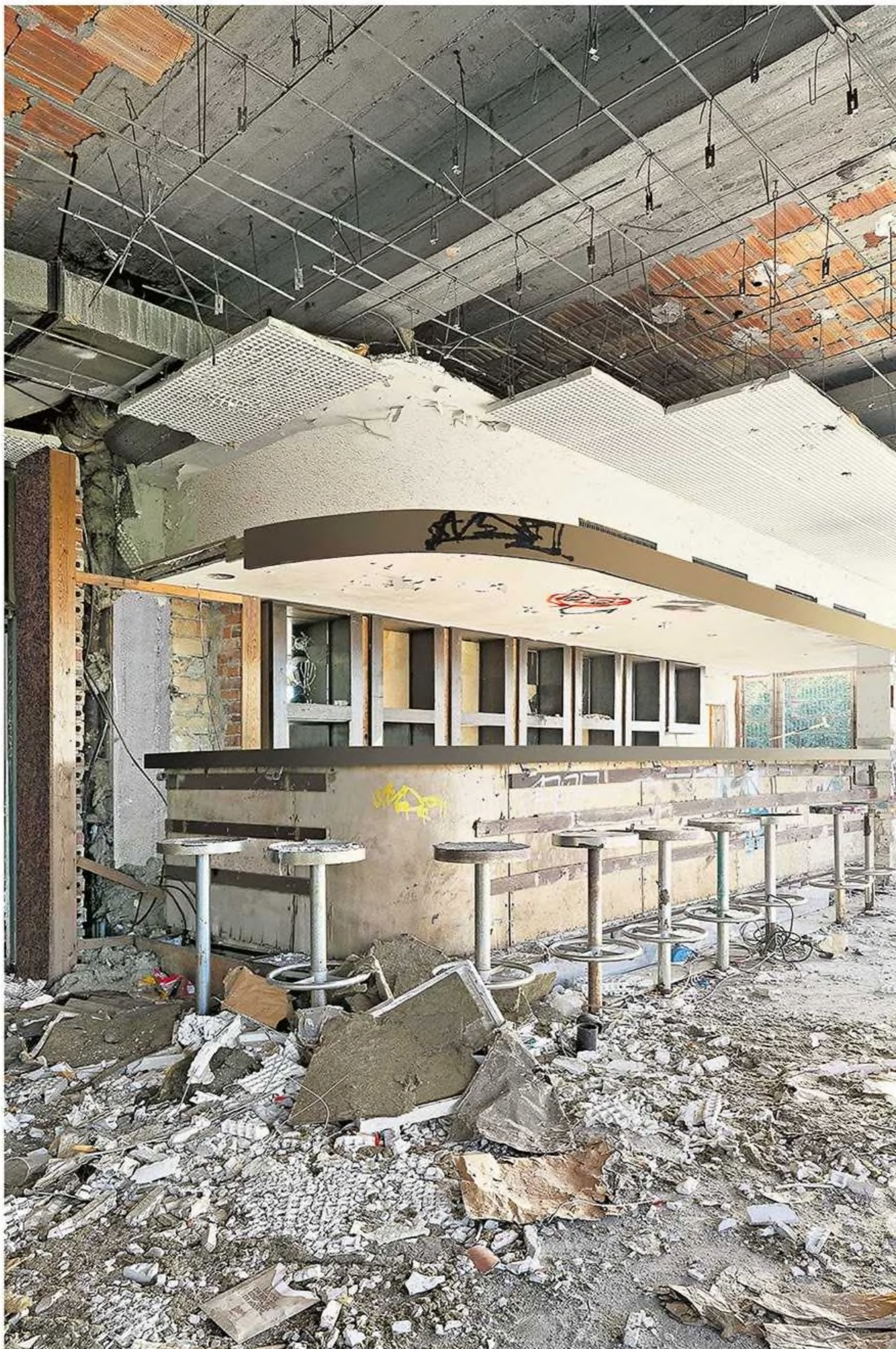
Das Restaurant Minsk in Potsdam war einst ein vergessener Ort. Inzwischen wird es umgebaut.
