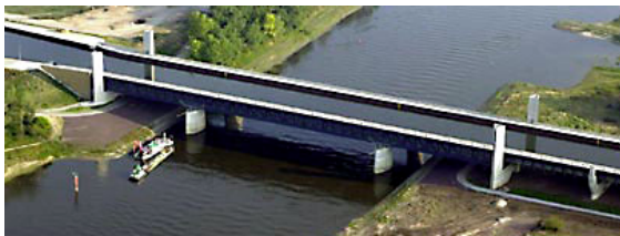
Die 900 m lange Trogbücke verbindet Mittelland- und Elbe-Havel-Kanal und führt über die Elbe.
