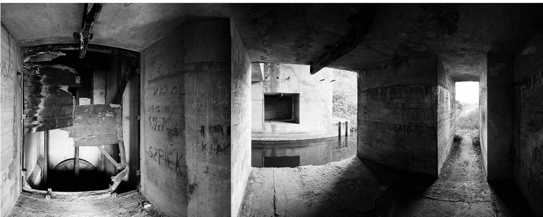
'Perspektiven', technische Anlagen einer nie genutzten Schleuse, Guya (PL), Rubrik Schleusen
